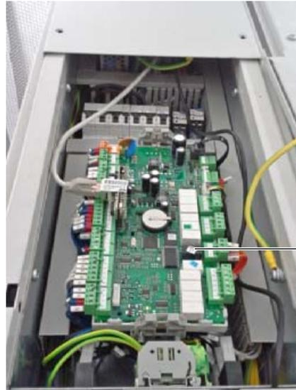
Abb. 2:  $\mu$ PC, Controller des LCP DX
