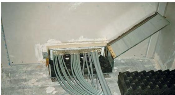
6. Anschließend den SRV um die bereits installierten Kabel und um die Kabelbox herum legen und an der Wand anschrauben.
