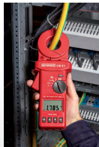
Mesure de la prise de terre du système d'une distribution industrielle
