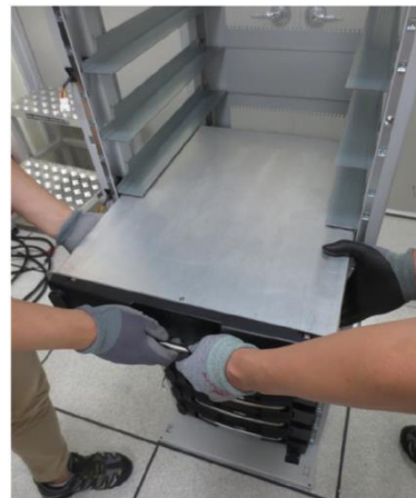
Abb. 18: Einbau der Batteriemodule
