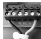
Figure 9: Raccordement d'une pompe / chaudière de 230 V à une barre de distribution de 24 V
