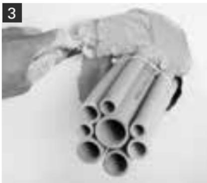
Anschließend ist die zum jeweiligen Leerrohrbündel passende, kleinste Brandschutzmanschette vom Typ AWM II auszuwählen. Der Ringspalt zwischen dem Elektroinstallationsrohr bzw. den Bündeln aus Elektroinstallationsrohren und der Brandschutzmanschette darf max. 15 mm betragen. Ist dies nicht der Fall,
