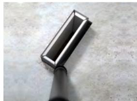
2. Die Öffnungslaubung muss staubfrei sein und sollte vor dem Einsetzen der Kabelbox angefeuchtet werden. Die Box muss so eingesetzt werden, dass der Spalt umlaufend auf keiner Seite breiter als 2 cm ist. Der Spalt wird dann vollständig mit EASYFOAM Brandschutzmontagschaum ausgefüllt.
