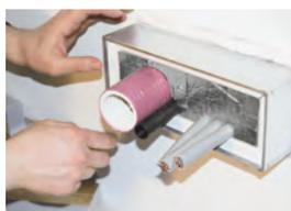
9. Der Stopfen wird mit der Folie nach außen in die Restöffnung eingesetzt. Reste können z.B. zur Abdichtung von Leerrohren genutzt werden.
