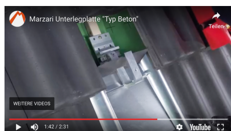
Montage der Metaldachplatte „Typ Beton“
