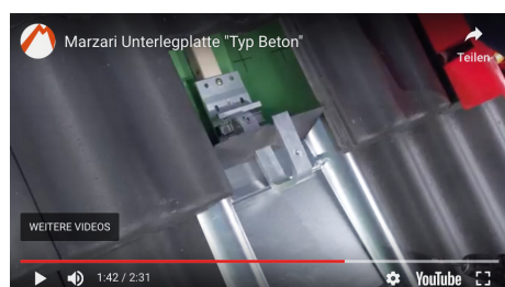
Montage der Metaldachplatte „Typ Beton“
