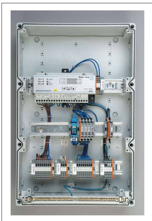
Innenansicht/Vue intérieure/Internal view
