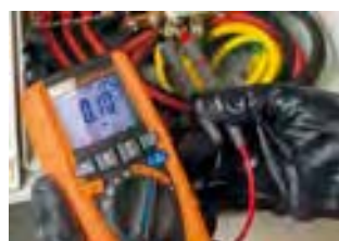
Durchgangsprüfung von Schutzleitern.
