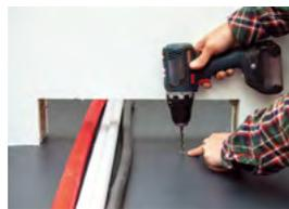
4. Löcher zum Festdübeln in den Beton bohren.
