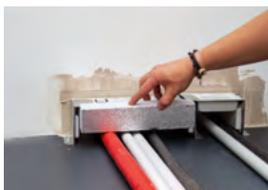
9. EasyFoam -Schaumstopfen den Kabeln entsprechend zuschneiden. Stopfen von beiden Seiten einsetzen bzw. bei einseitiger Zugänglichkeit von einer Seite 3 Stopfen hintereinander.
