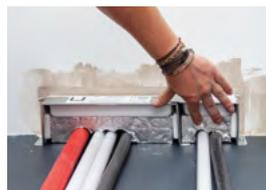
10. Der Stopfen wird mit der Restöffnung eingesetzt. Reste können z.B. zur Abdichtung von Leerrohren genutzt werden.
