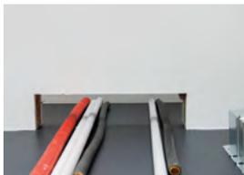
1. Kabelverlegung auf dem Boden. Der Boden unterhalb der Abschottung muss eben und nicht brennbar sein.
