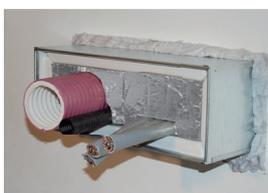
9. Der Stopfen wird mit der Folie nach außen in die Restöffnung eingesetzt. Reste können z.B. zur Abdichtung von Leerrohren genutzt werden.
