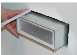
4. Kabelbox so in die Öffnung einsetzen, dass nirgends mehr als 8,5 cm aus der Wand stehen. Die Grafitstreifen müssen innerhalb der Wand sein.
