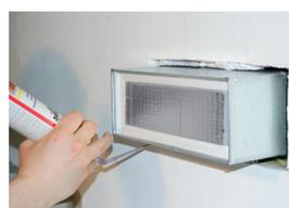
5. Die Kabelbox wird dann in Wandtiefe vollständig eingeschäumt. Das Spaltmaß darf maximal 2 cm betragen.
