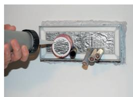
10a. Danach werden alle Restöffnungen mit einem dauerelastischen Dicht- stoff, wie z.B. Silikon oder Acryl, rauchdicht verschlossen.
